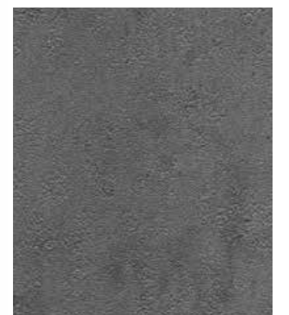
Concrete | 콘크리트 MG/MF 986
